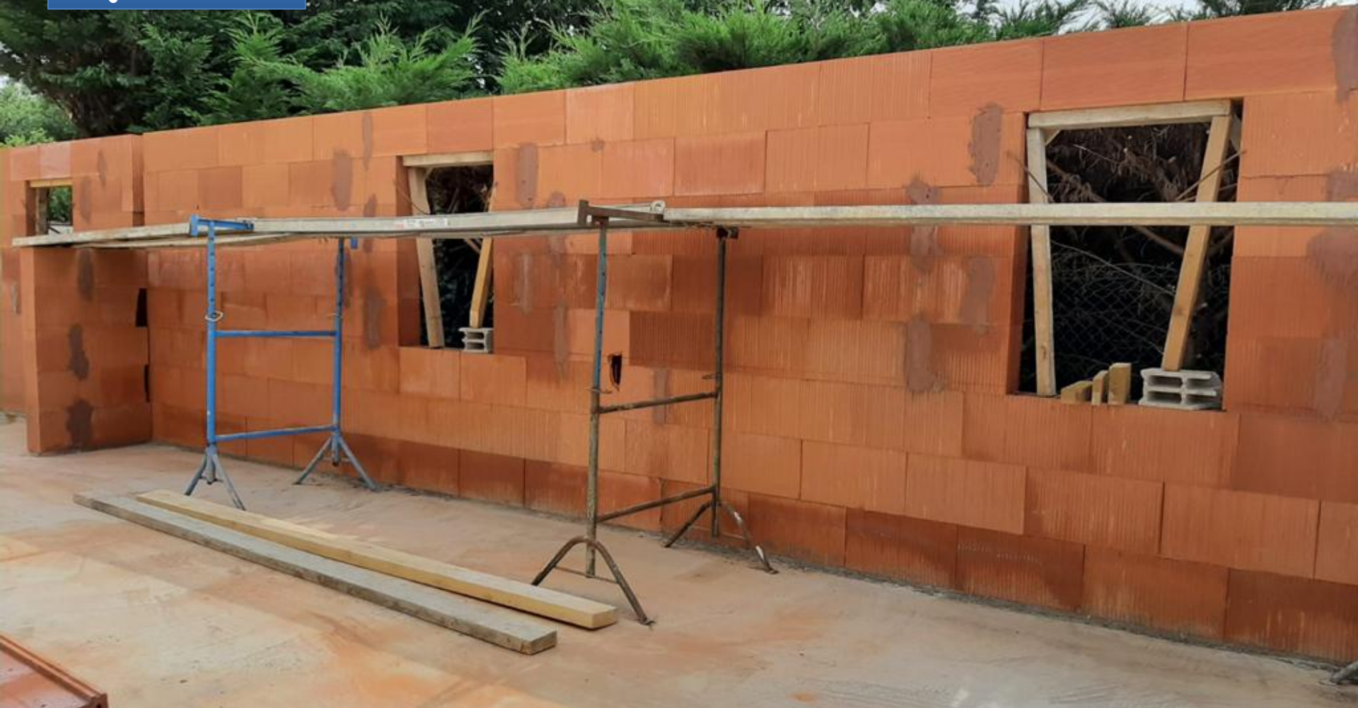
Avancement des travaux : la salle du fond en gestation
